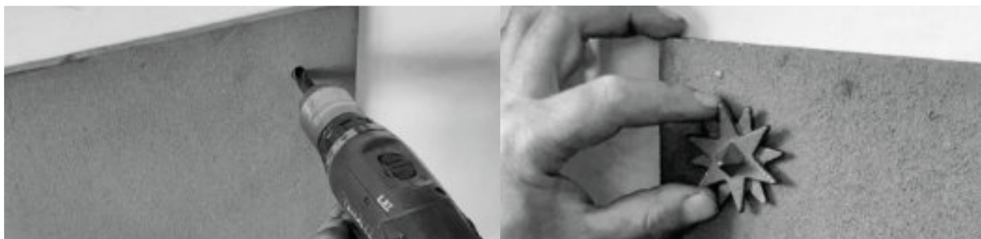
ESEMPIO 1: Fissaggio lastra con Grapin / Grastar
